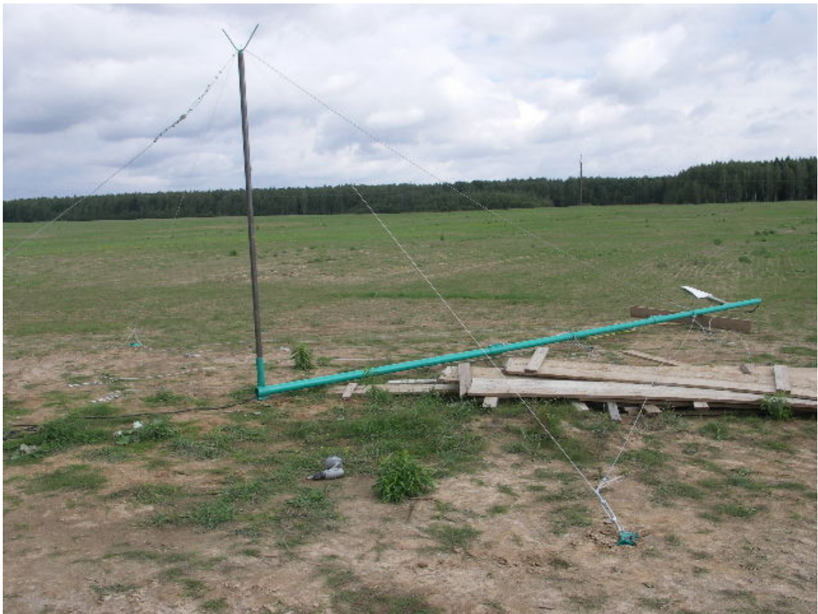
Рисунок 19 Мачта перед подъемом без генератора
