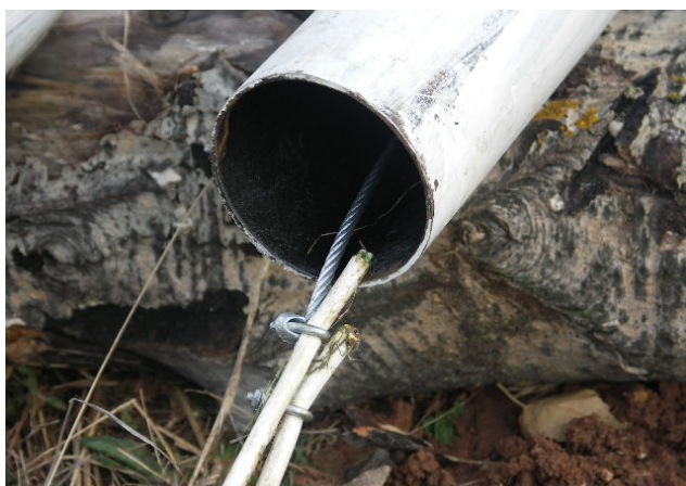
Рисунок 15 Протягивание кабеля через мачту
