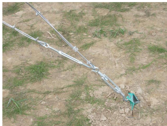
Рисунок 18 Крепление растяжек в 2 яруса
