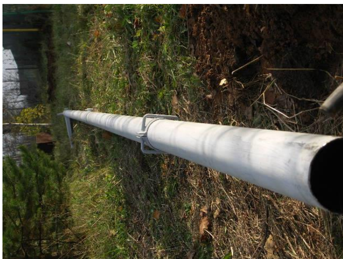
Рисунок 16 Вид хомута для растяжек
