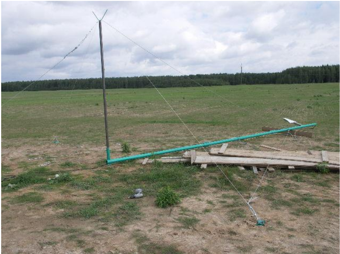
Рисунок 19 Мачта перед подъемом без генератора
