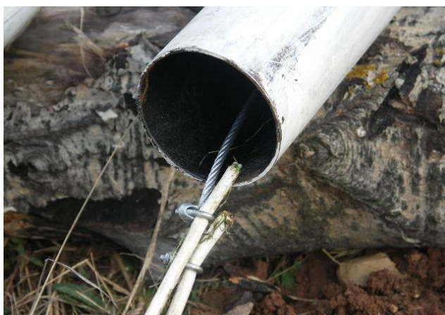
Рисунок 15 Протягивание кабеля через мачту
