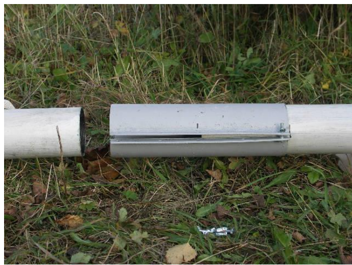
Рисунок 17 Вид соединительного хомута для труб
