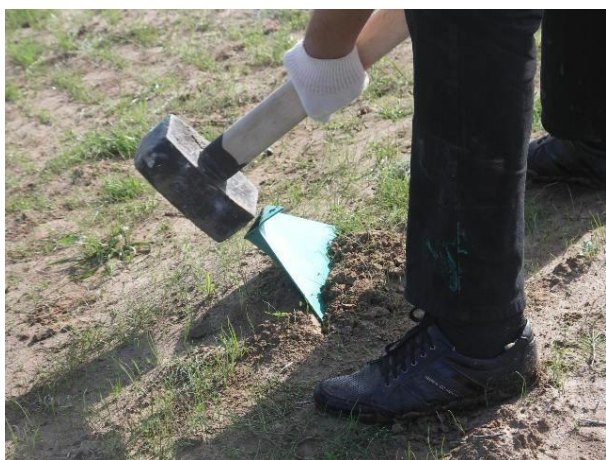
Рисунок 6 Якорь для растяжки
