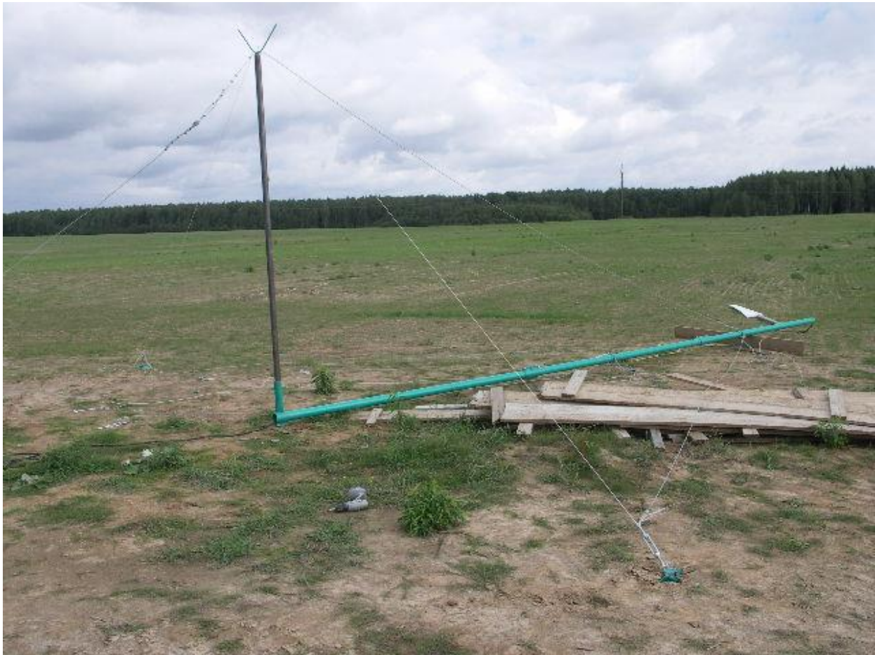
Рисунок 14 Мачта перед подъемом без генератора
