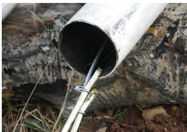
Рисунок 10 Протягивание кабеля через мачту
