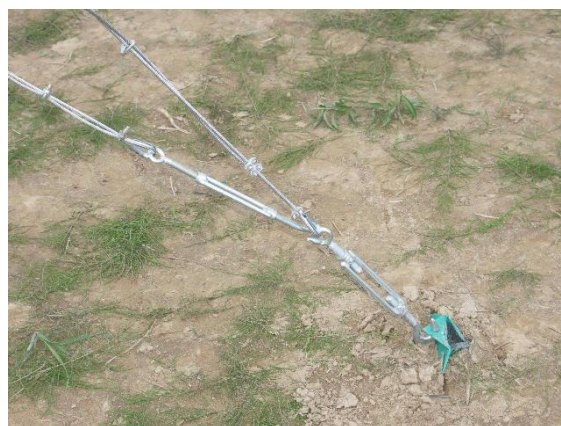
Рисунок 13 Крепление растяжек в 2 яруса
