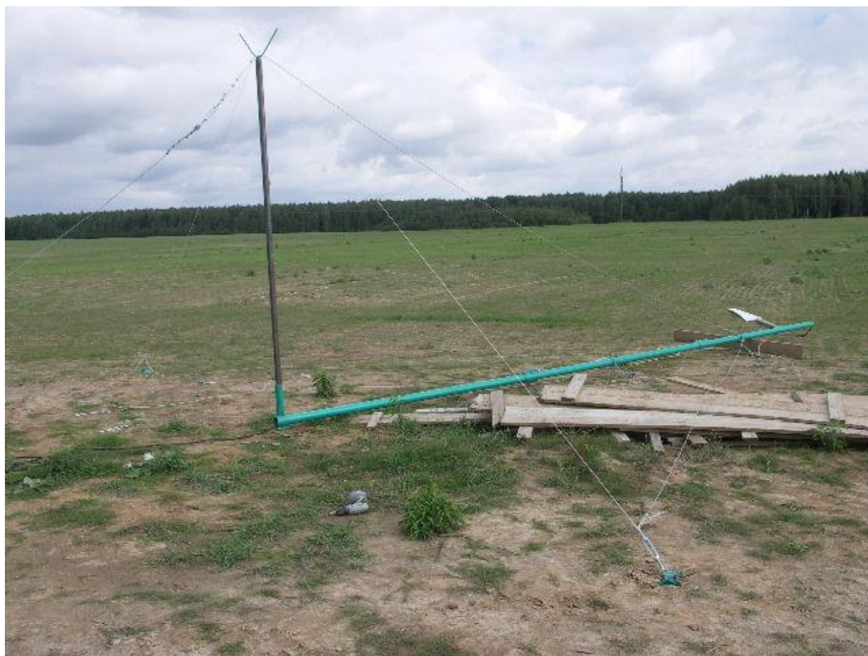
Рисунок 14 Мачта перед подъемом без генератора
