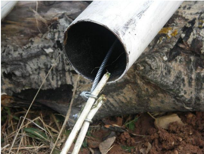
Рисунок 10 Протягивание кабеля через мачту
