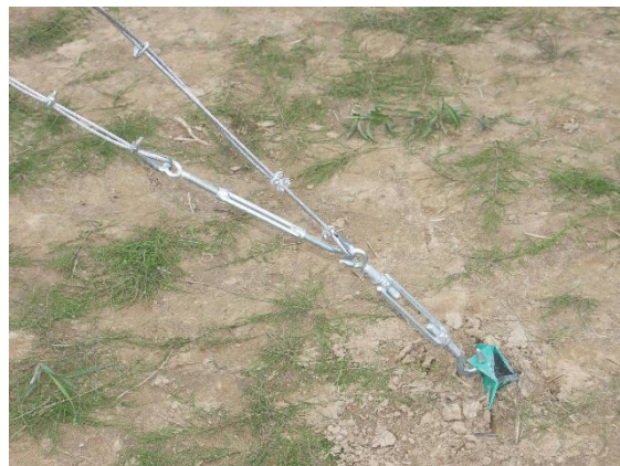
Рисунок 13 Крепление растяжек в 2 яруса
