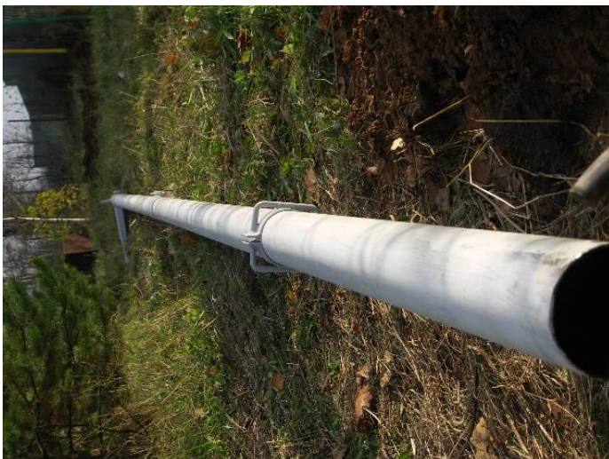
Рисунок 11 Вид хомута для растяжек
